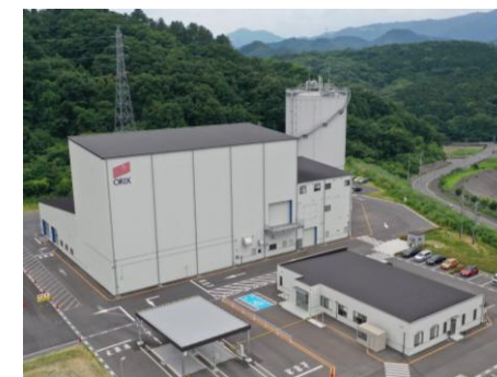
寄居バイオガスプラント [3] バイオマス資源: 紙ごみ、生ごみ、草木類 方式: 乾式メタン発酵
