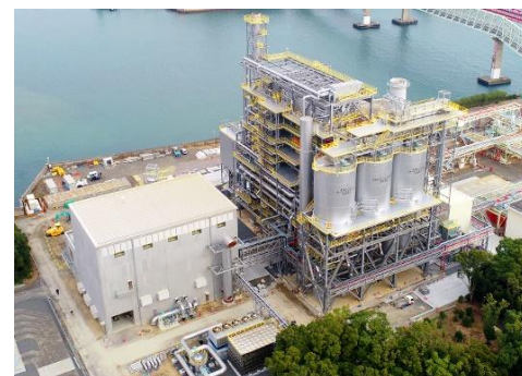
四日市バイオマス発電所 [2] バイオマス資源: 木質燃料、パーム椰子殻 方式: 直接燃焼
