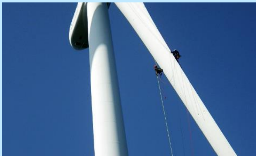
図 37 ロープワークによる重機を用いないブレード点検の様子
