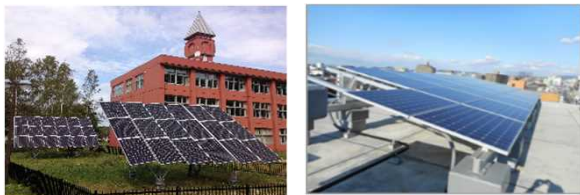
避難施設等に設置した再エネ・蓄エネ設備
