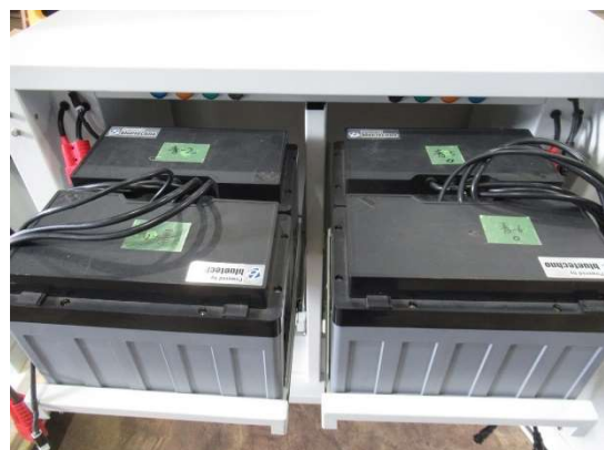
電池ラックを引き出した （上段 4 個の電池を引出した）
