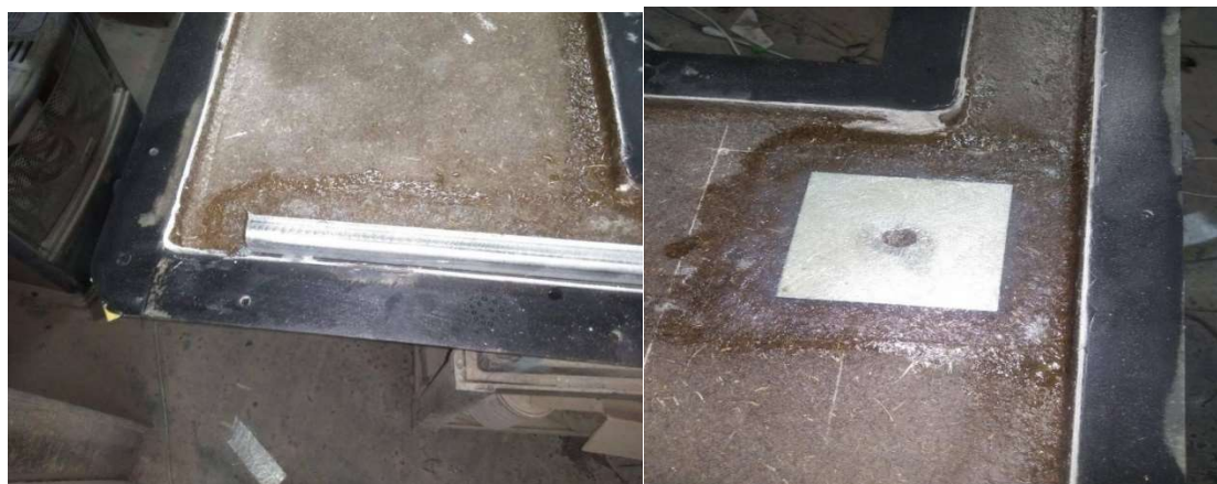
図 2.1.1.2-2 ドア補強材の様子
