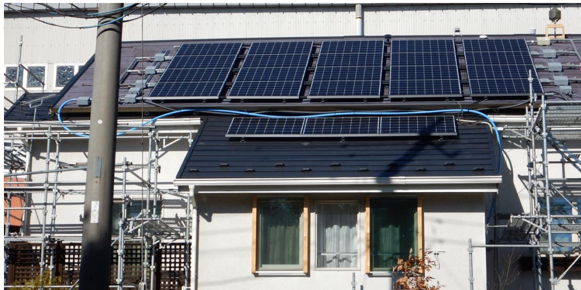
写真4. 埼玉実棟実験棟 試験状況 (上側20枚が開発パネル、下側3枚は比較用発電パネル)
