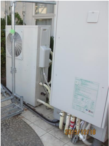
写真 3．実棟設置状況 （埼玉）
