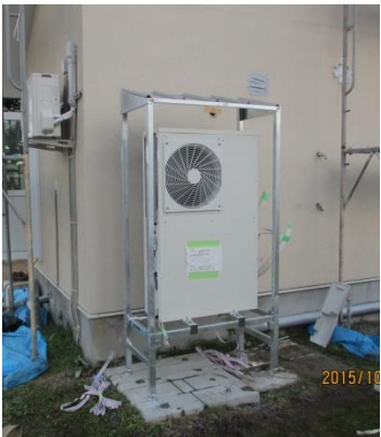
写真 2．実棟設置状況 （旭川）
