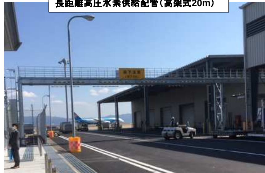
長距離高圧水素供給配管(高架式20m)
