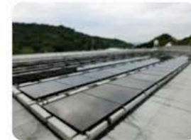
屋上: 太陽光パネル (PV) 1.8 kW
