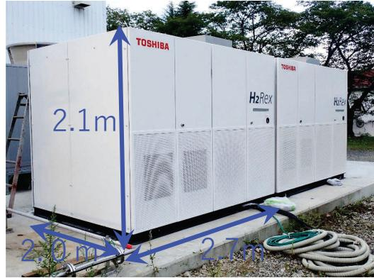
低コスト100kW純水素燃料電池モジュール
