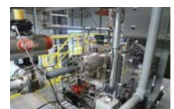
発電後の熱水を利用した施設(十日町市が実施)タービン効率77.4%(平均)を達成したアンモニア用永久磁石式高速タービン発電機(87kW)
