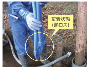
従来の採熱方式(Uチューブ)
