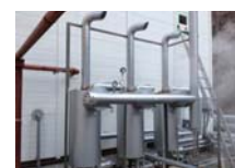
未利用蒸気熱回収用熱交換器
