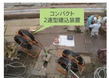
高速建込装置(短工期施工)
