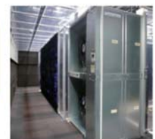
省エネ型空調機とサーバーラック(京阪奈仮設データセンターにて)
