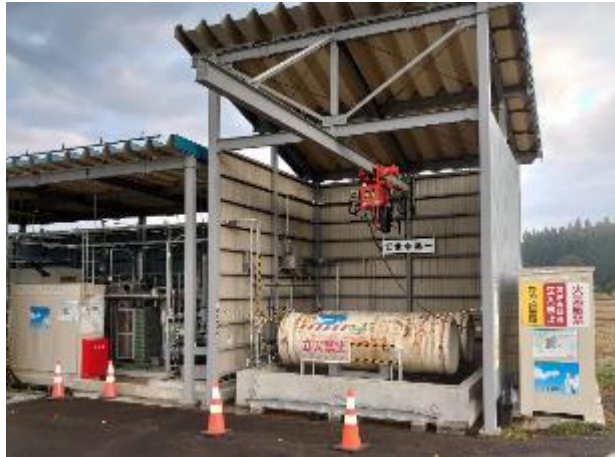
実証設備(MGT、NH 3 供給設備)
