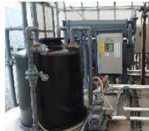
吸収式冷凍機 (MGT温水利用により冷熱生成)
