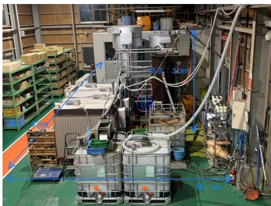
実証試験装置の外観
