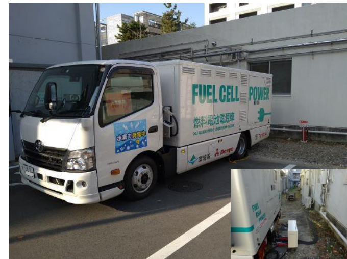
大規模停電時の避難所を模擬した建物へ給電
