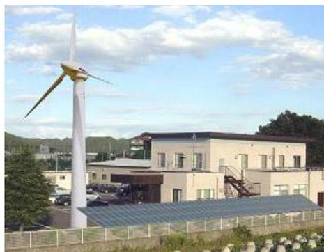
風力: 40kW, 太陽光: 20kW, 模擬電源: 10kW, 水電解水素製造: 10kW, 燃料電池: 10kW
