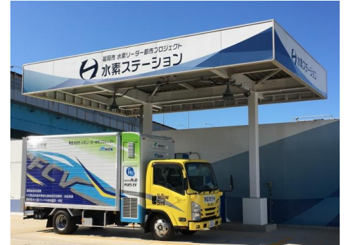
福岡市中部水処理センターによる 下水バイオガス由来水素の充填 (令和元年度)
