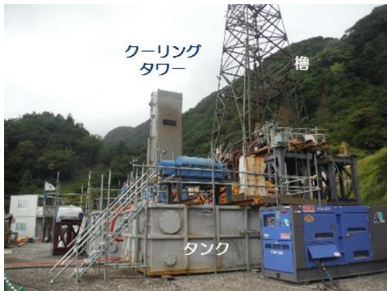
写真② 掘削設備の設置状況
