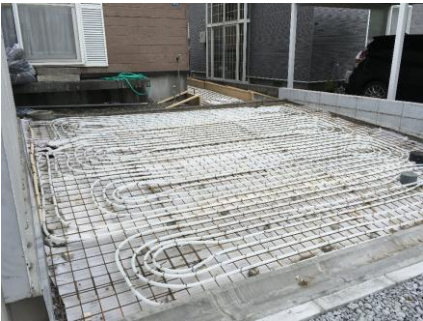
放熱管パイピング状況
