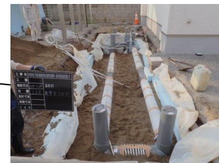
貯水管、採熱管、断熱材設置状況
