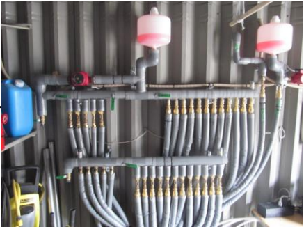
ポンプ、ヘッダー類設置状況
