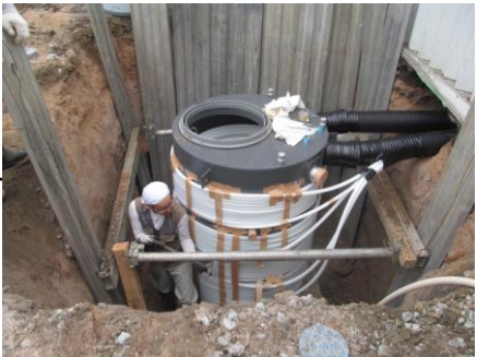
貯水槽、採熱管、設置状況
