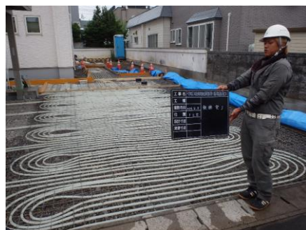
放熱管パイピング状況
