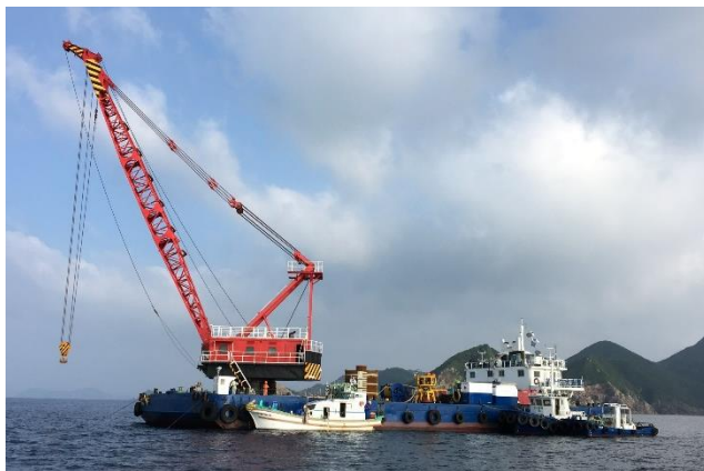
サクシオンアンカー本施工 (2016.6.26)
