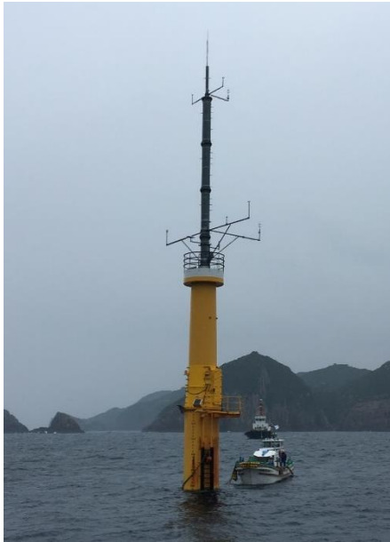
浮体式風況観測タワー
