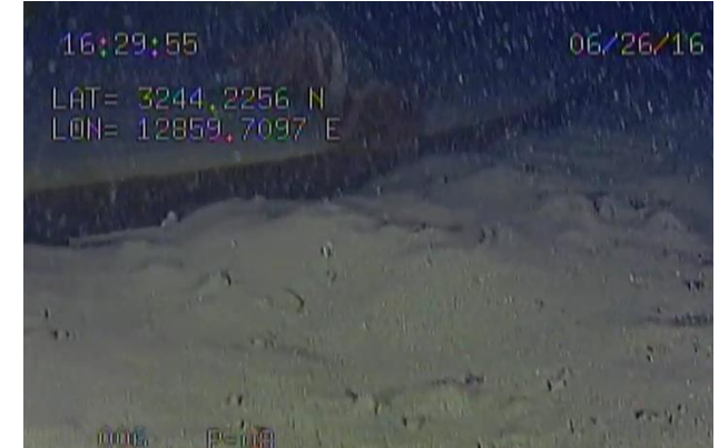
サクシオンアンカー打設 完了を示す海中映像
