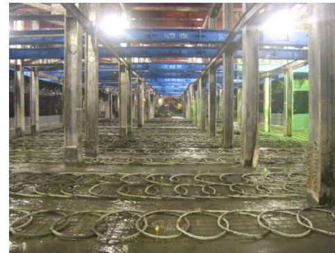
地下3F 水平型 地中熱交換器 敷設状況
