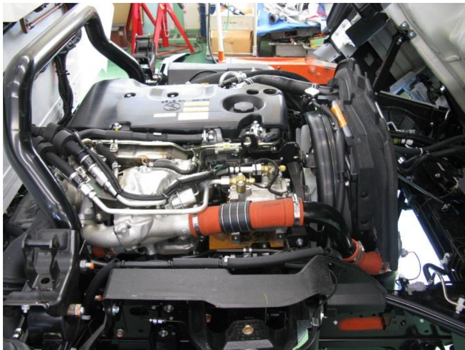
改造前エンジンルーム
