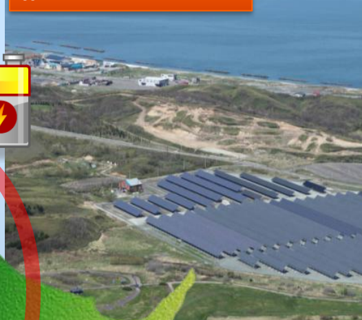
稚内PV 1.00MW
