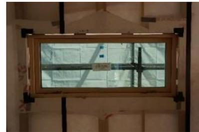
実証試験体躯体超断熱サッシ据付状況
