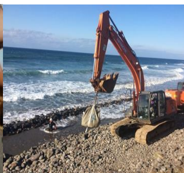
施肥材 埋設状況
