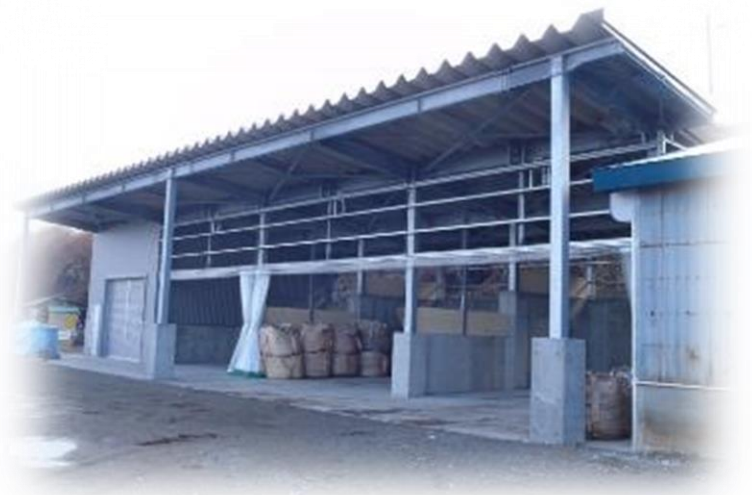
独自の堆肥製造施設
