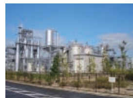
バイオエタノール生産プラント
