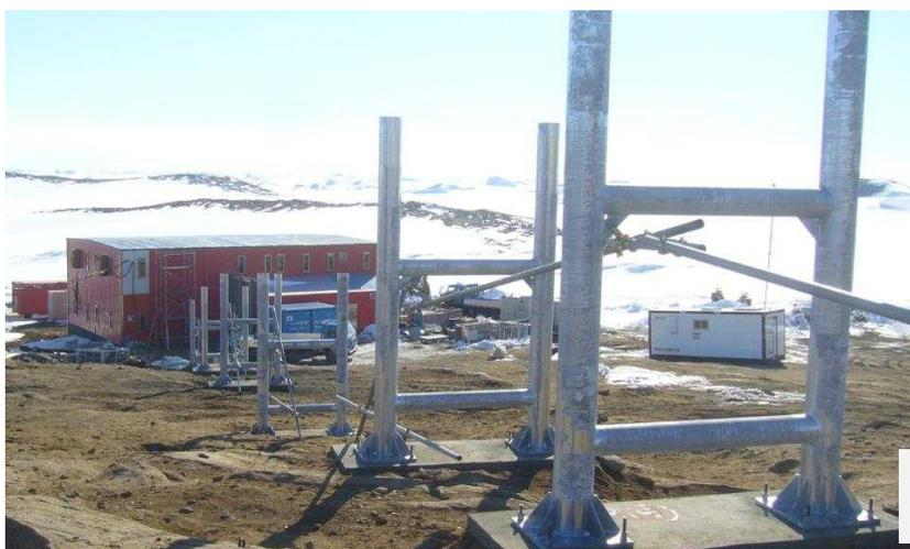
図6-2 汚水配管架台
