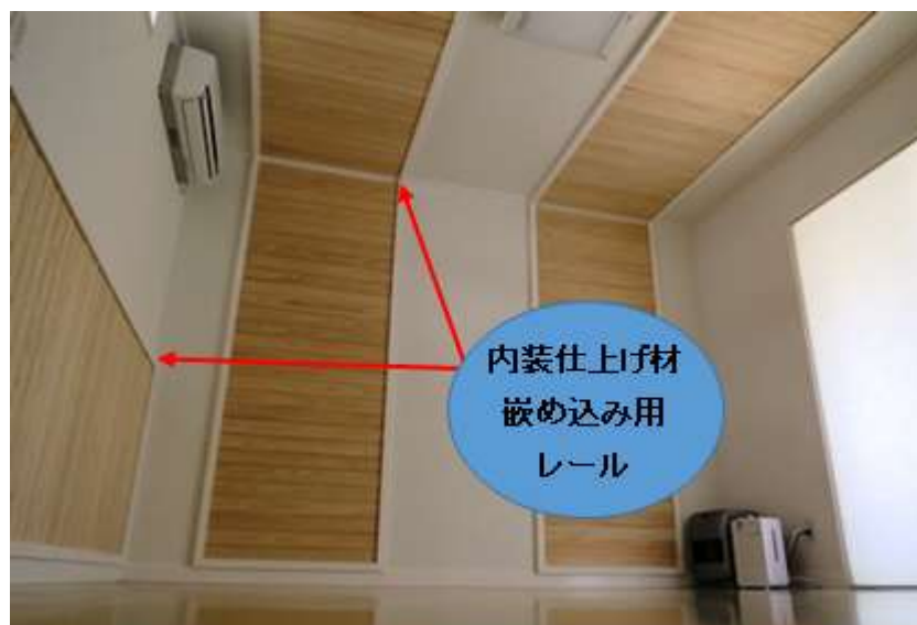
図 40 テストハウス室内に設けられている内装仕上げ材嵌め込み用レール
