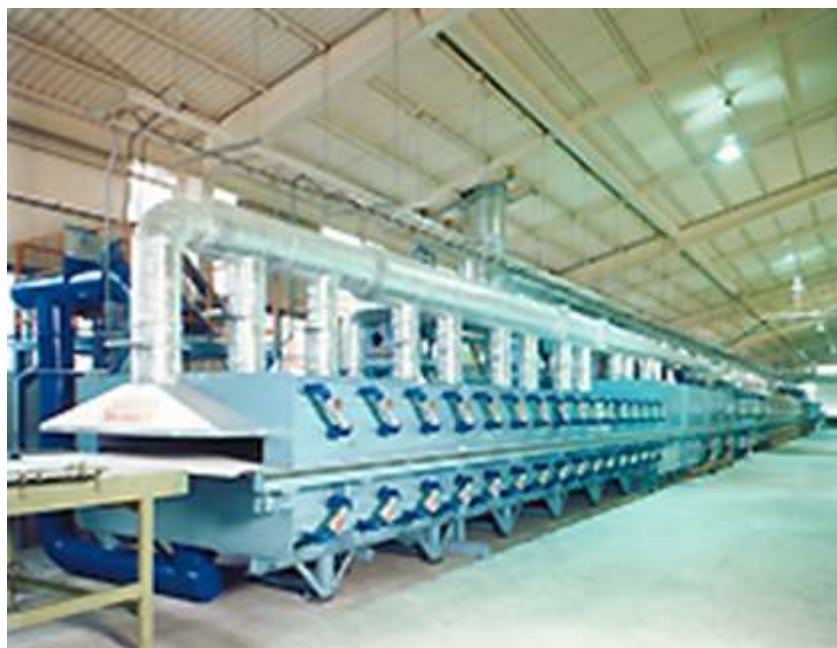
図 26 養生用に用いた連続乾燥炉の外観
