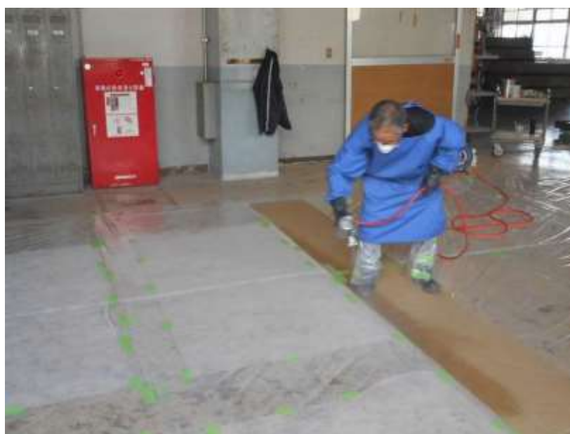
図 167 ガラスペーパーへの CNF 吹き付け作業
