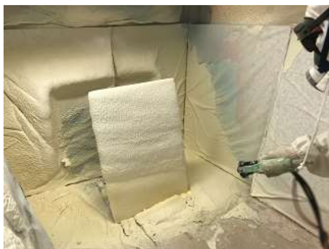
図 192 ウレタン吹付工程写真 (CNF 添加有)
