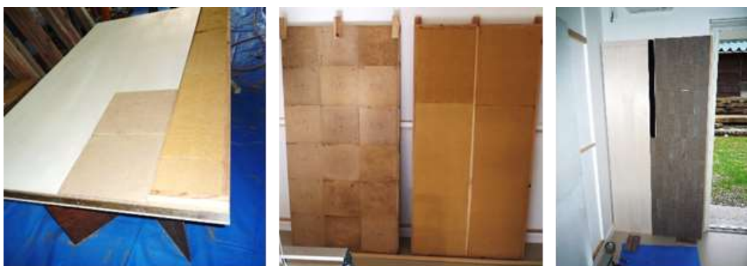
図 35 外壁部品の作成・取付の様子
