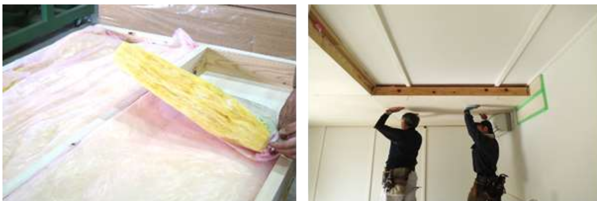
図 68 天井部品 (パネル) 作成と取り付けの様子
