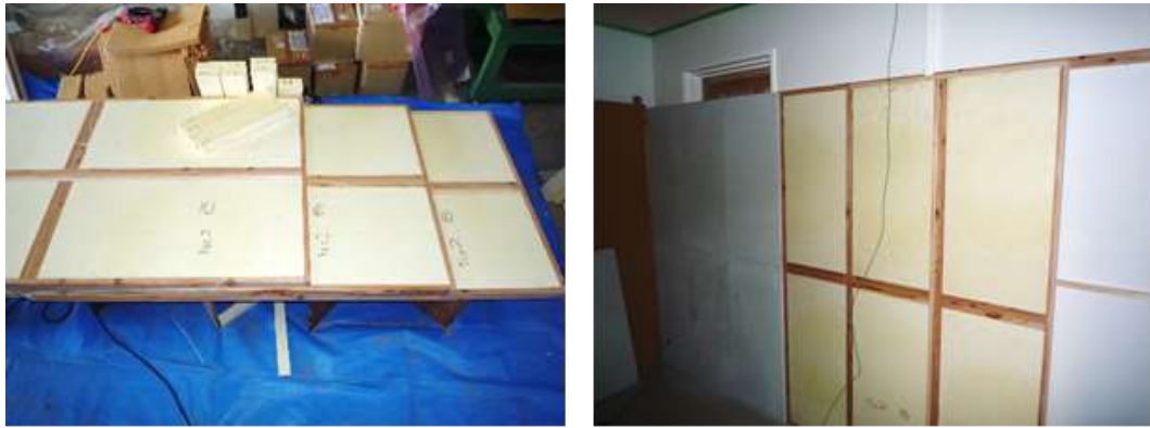
図 159 内装部品 (パネル) 作成と取り付けの様子
