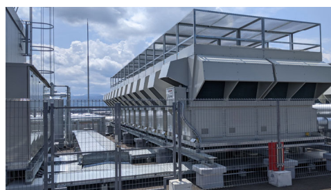
イオンモール白山の断熱・空調設備
