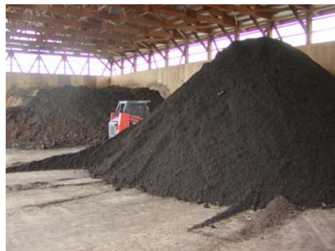
堆肥化施設状況
