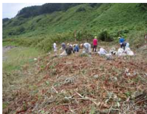
人力による回収（B 区域）
