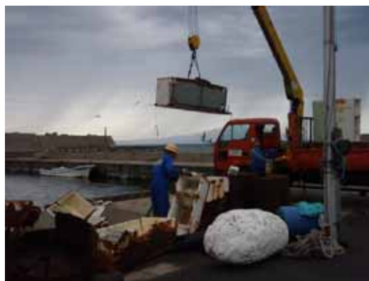
法木港での積み込み（第5回目）
