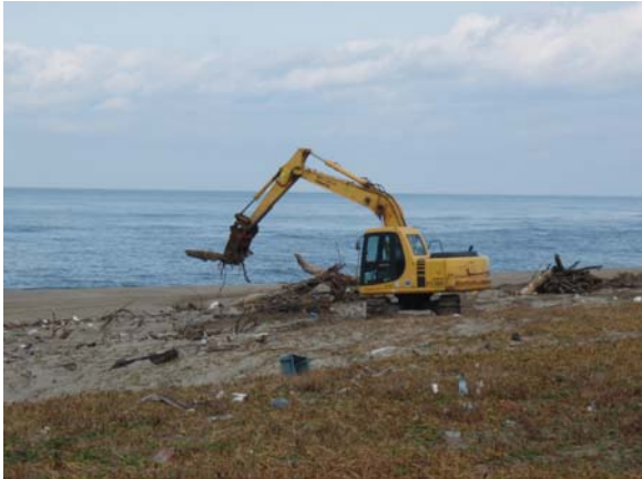
バックホウによる回収（平成 19 年 11 月）
