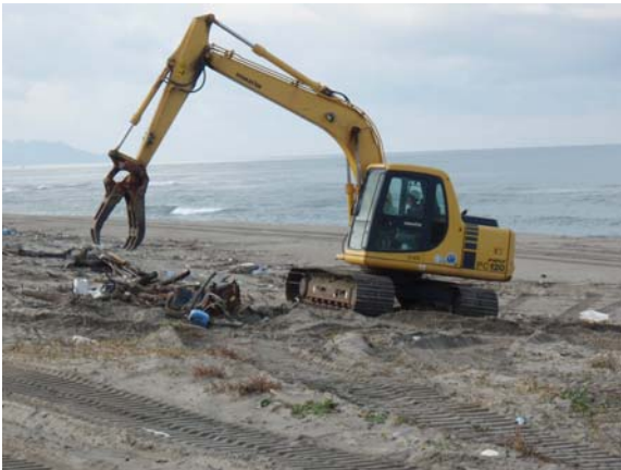
バックホウによる回収（平成 19 年 10 月）
