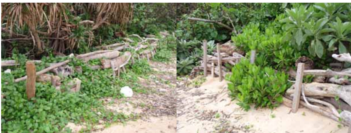
図 2.1-7 西表島で実施した流木の流出防止措置（杭による固定）
