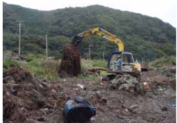
重機による回収（第1回調査）
