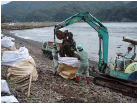
重機による回収（第1回調査）
