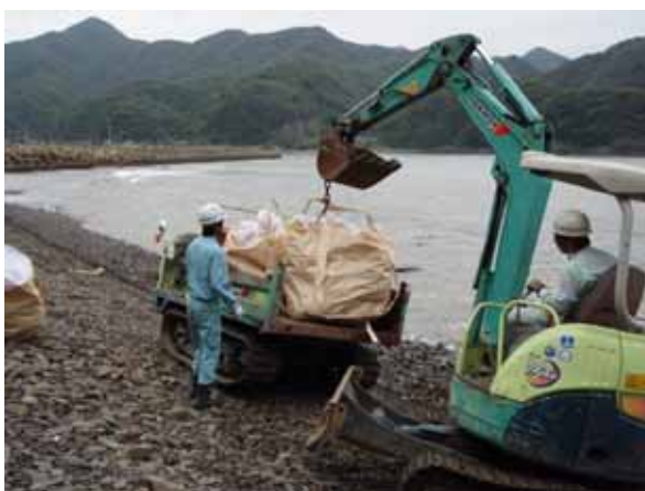
重機による不整地車両への積み込み
