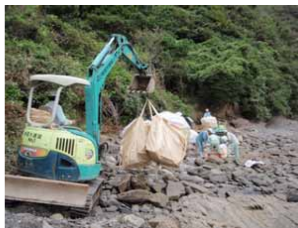
重機による運搬
