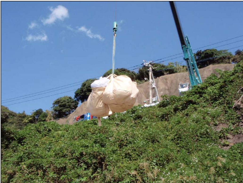
図 13 志多留地区のゴミ回収の様様（クレーンによる吊り上げ作業）
