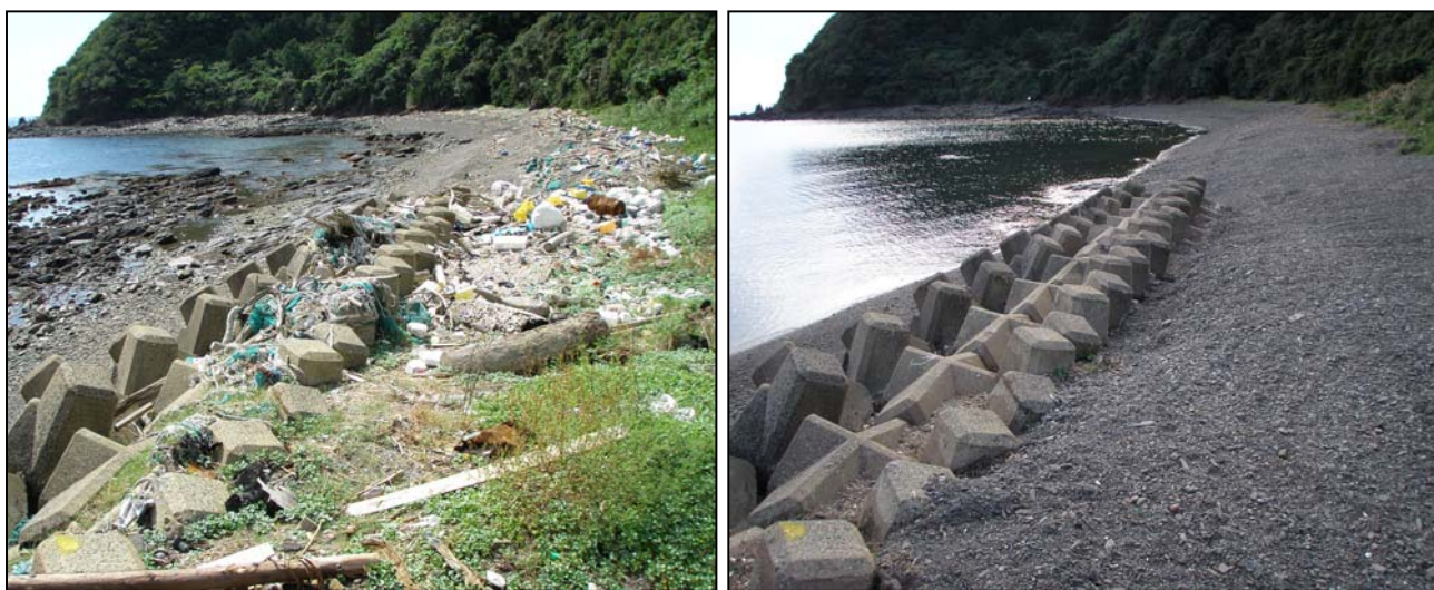
図 26 回収前後の状況（左が回収前、右が回収後）
