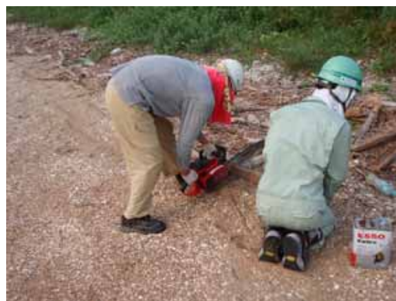
チェーンソーによる流木切断作業
