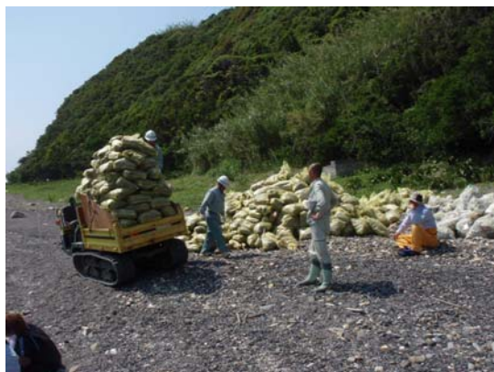
図 2.2-1 不整地車両による搬出
