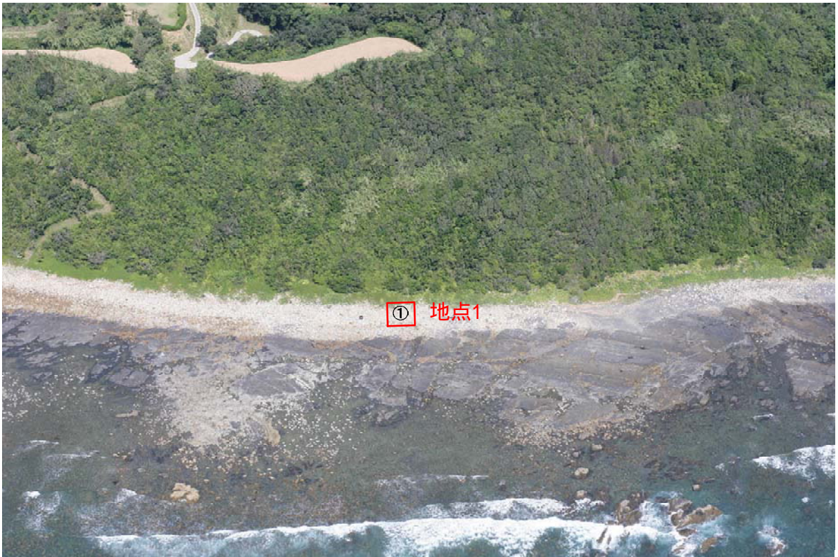
図 3.1-5(1) 調査枠の設置状況 (地点 1)
