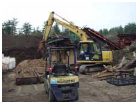
選別機にて選別作業中
