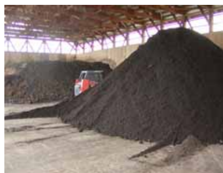
堆肥化施設状況
