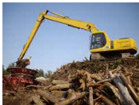
破砕処理プラント
