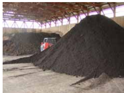
堆肥化施設状況
