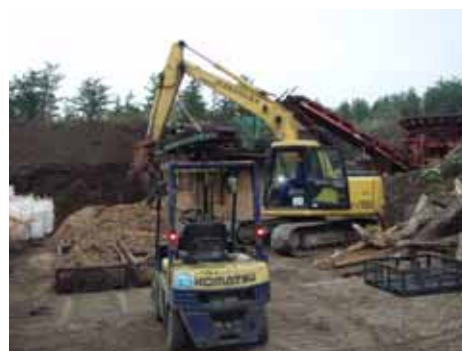
選別機にて選別作業中
