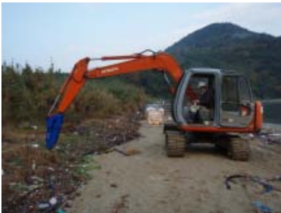
バックホウによる流木の撤去
