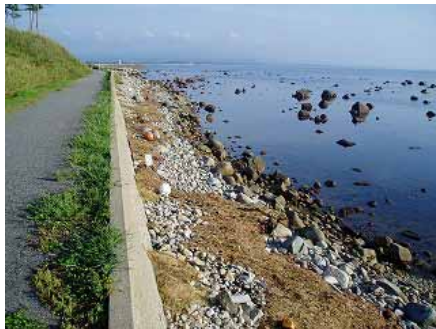
地点 7 の状況（現地踏査）
