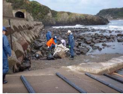
回収作業（中の間）
