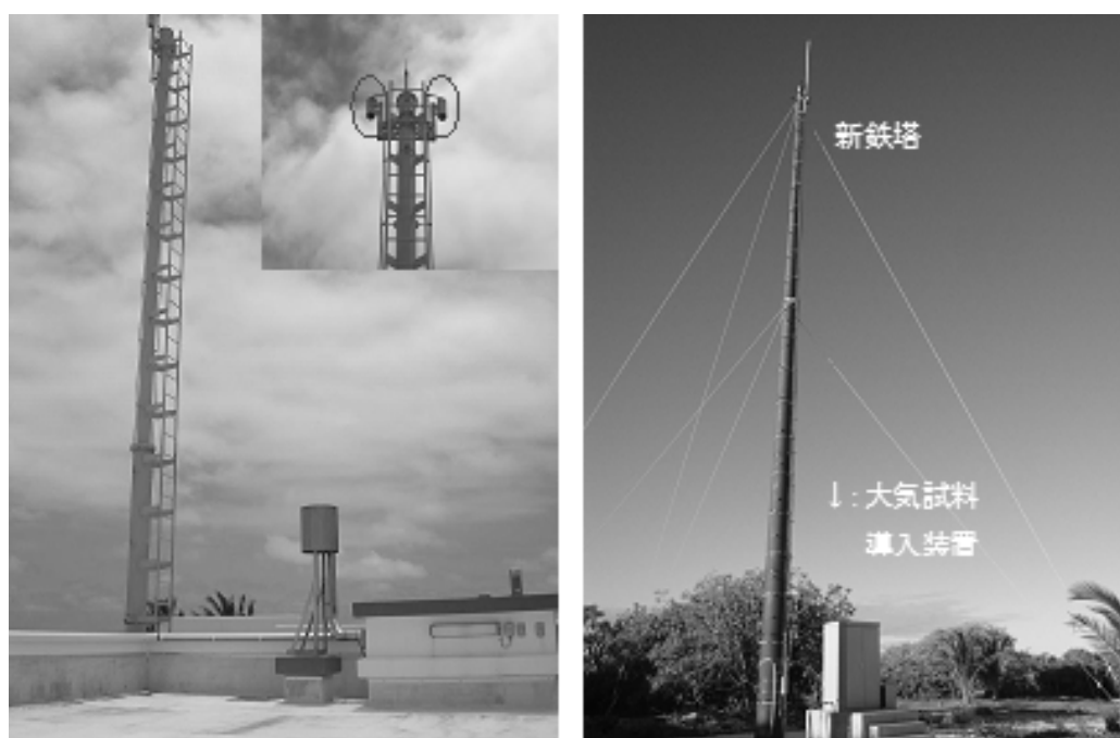
図2. 南鳥島の大气環境観測用の試料採取鉄塔（左：旧鉄塔、右：新鉄塔）。
