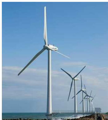
茨城県神栖市の洋上風力発電(現在も稼働中)
