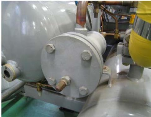
④ 機械式継手とフランジ
