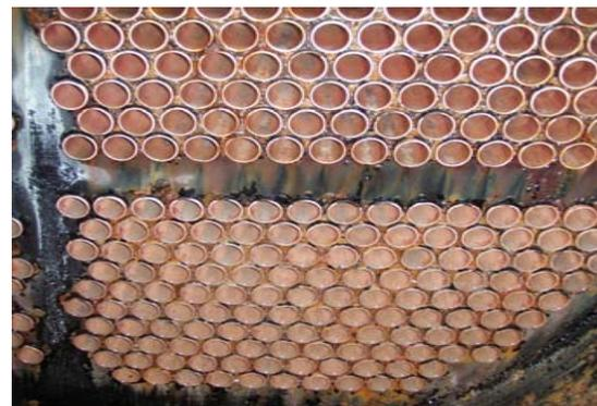
水冷熱交換器伝熱管の劣化
