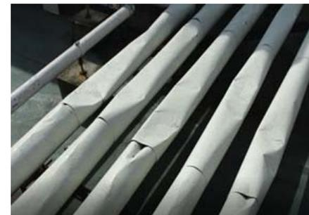
冷媒配管の防熱の損傷
