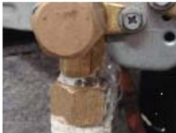
ピンポイントの漏えい検知に適している。漏えい可能性のある箇所を発泡液を塗布し、吹き出すフロンを検知。
