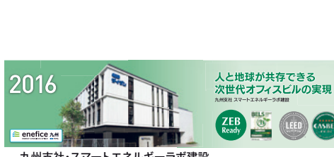
九州支社・スマートエネルギーラボ建設
