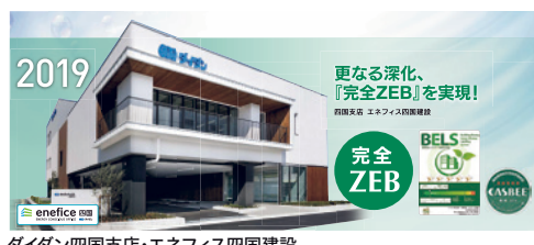
ダイダン四国支店・エネフィス四国建設
