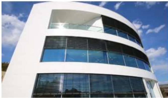
藤崎建設工業 本社ビル (外観、太陽追尾式外付けブラインド)
