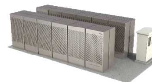
自立型電源（蓄電池設備含む）
