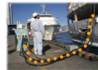
電力供給設備
