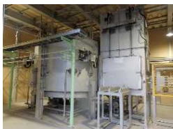
<Li-ion電池リサイクル設備>
