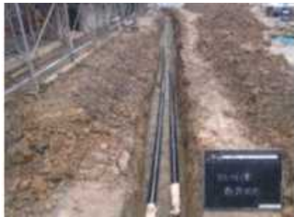
熱輸送施設 (熱輸送管 L=141m)
