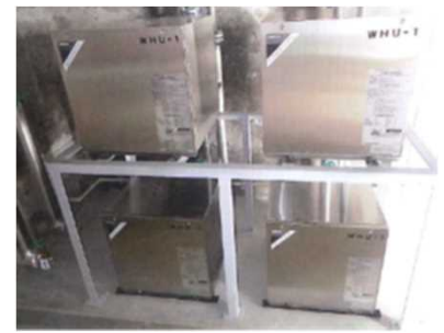
熱利用施設 (ヒートポンプ10kw×5台)
