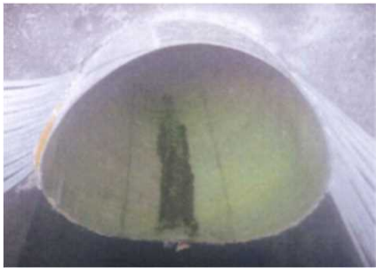
採熱施設 (下水管路内採熱管 L=65m)
