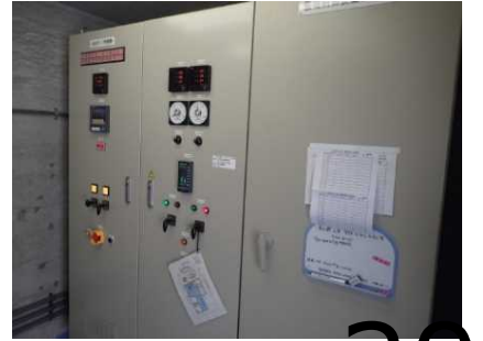
ポンプ制御盤 インバータ機器(5.5kW)
