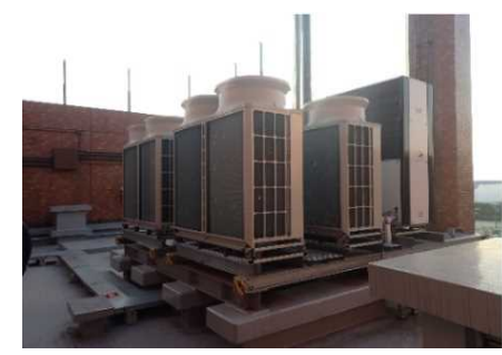
高効率空調設備
